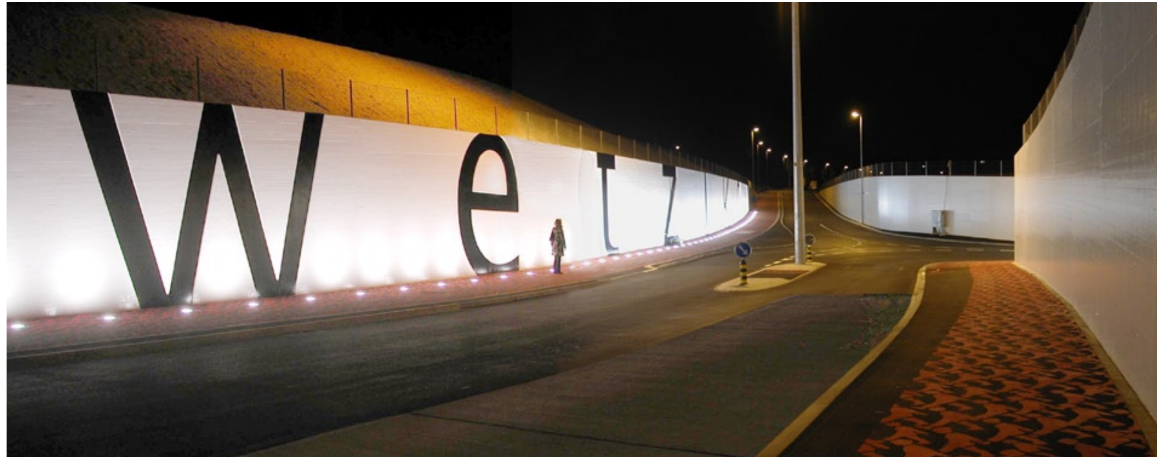
Fertig gestelltes Bauwerk 14. Juli 2004, 22:20
