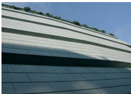
Monolith - Egender im ausgesparten südlichen Baufeld
