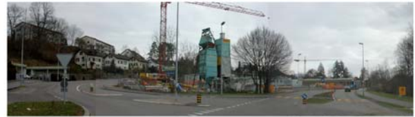
Baustelle ARA Flos am 25. Februar 2001
